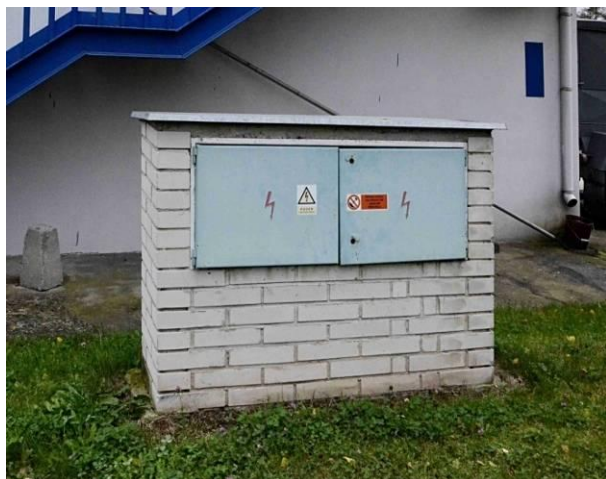
Propojovací skříň trafo T2
